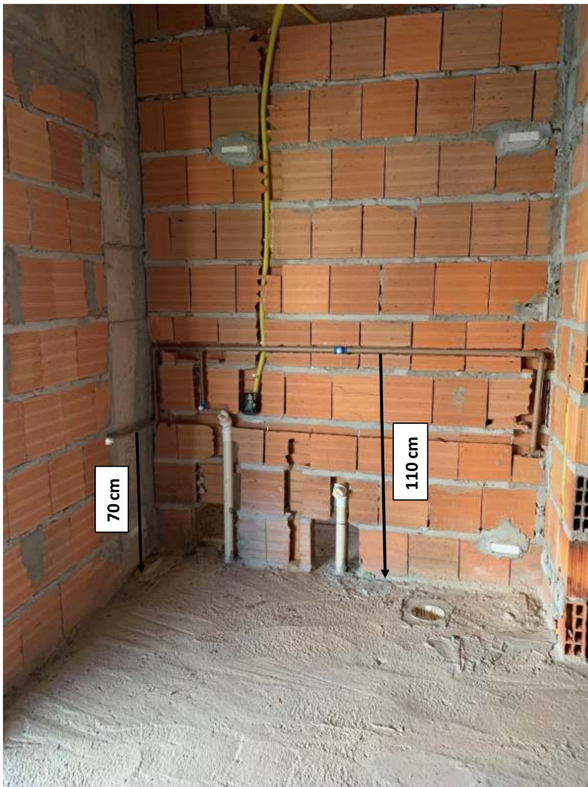
Foto 1: Área de serviço
