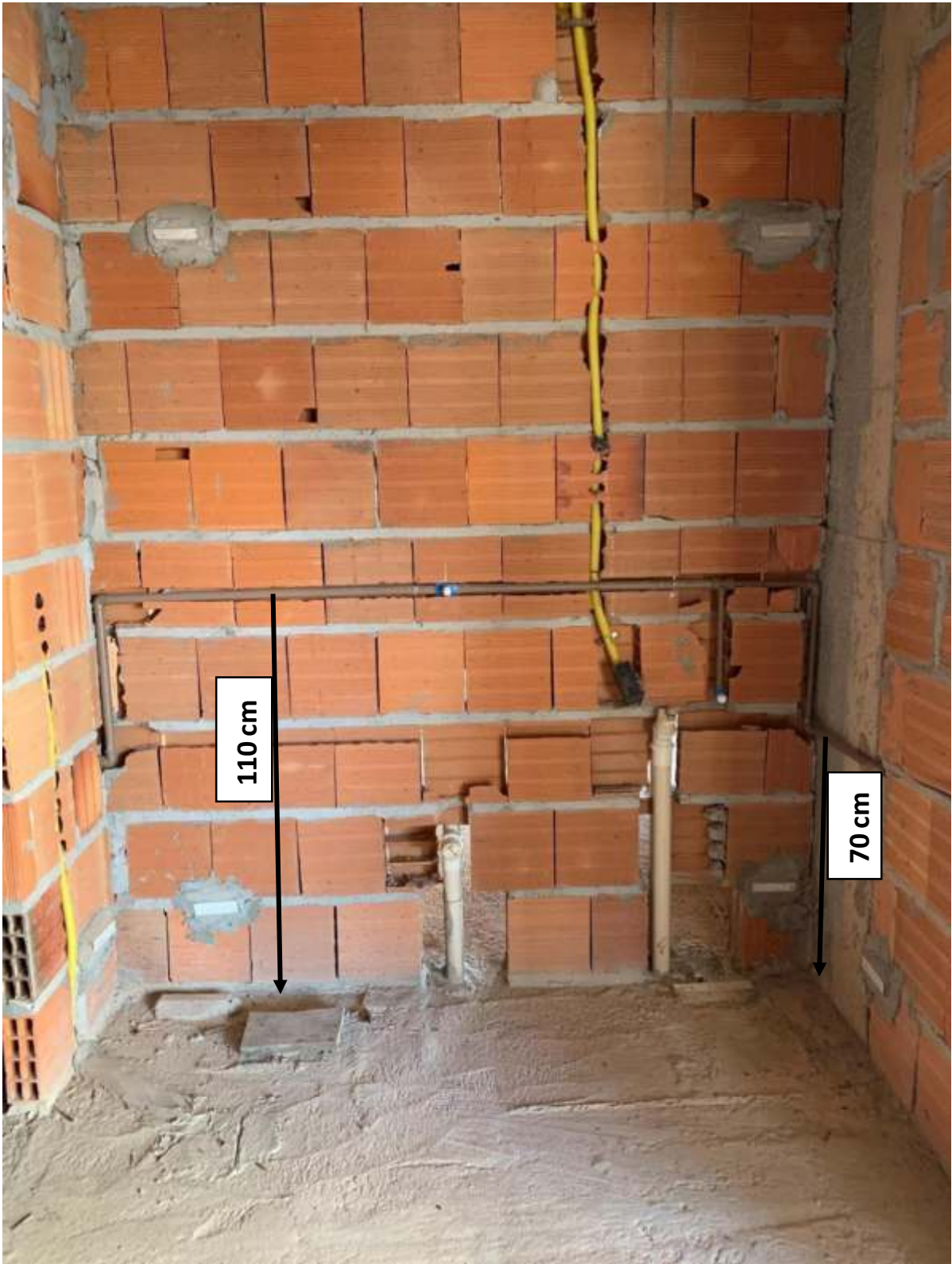
Foto 1: Área de serviço
